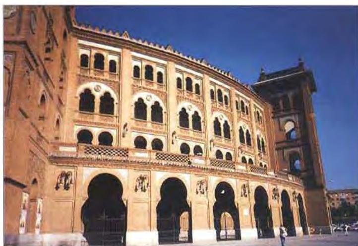
Las obras sólo afectan a los edificios y servicios de WC de la plaza
