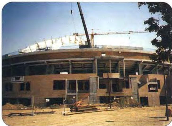
Las gruas colocan uno de los gajos de esta cúpula, que pesará un total de un millón trescientos mil kilos.
