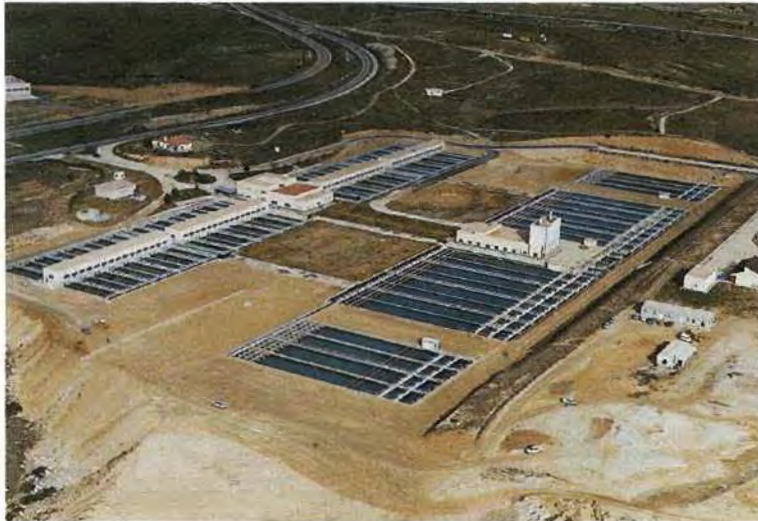
ESTACION DE TRATAMIENTO DE AGUA DE COLMENAR
