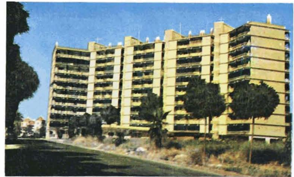
Edificio Residencial "Nervión"-Sevilla
