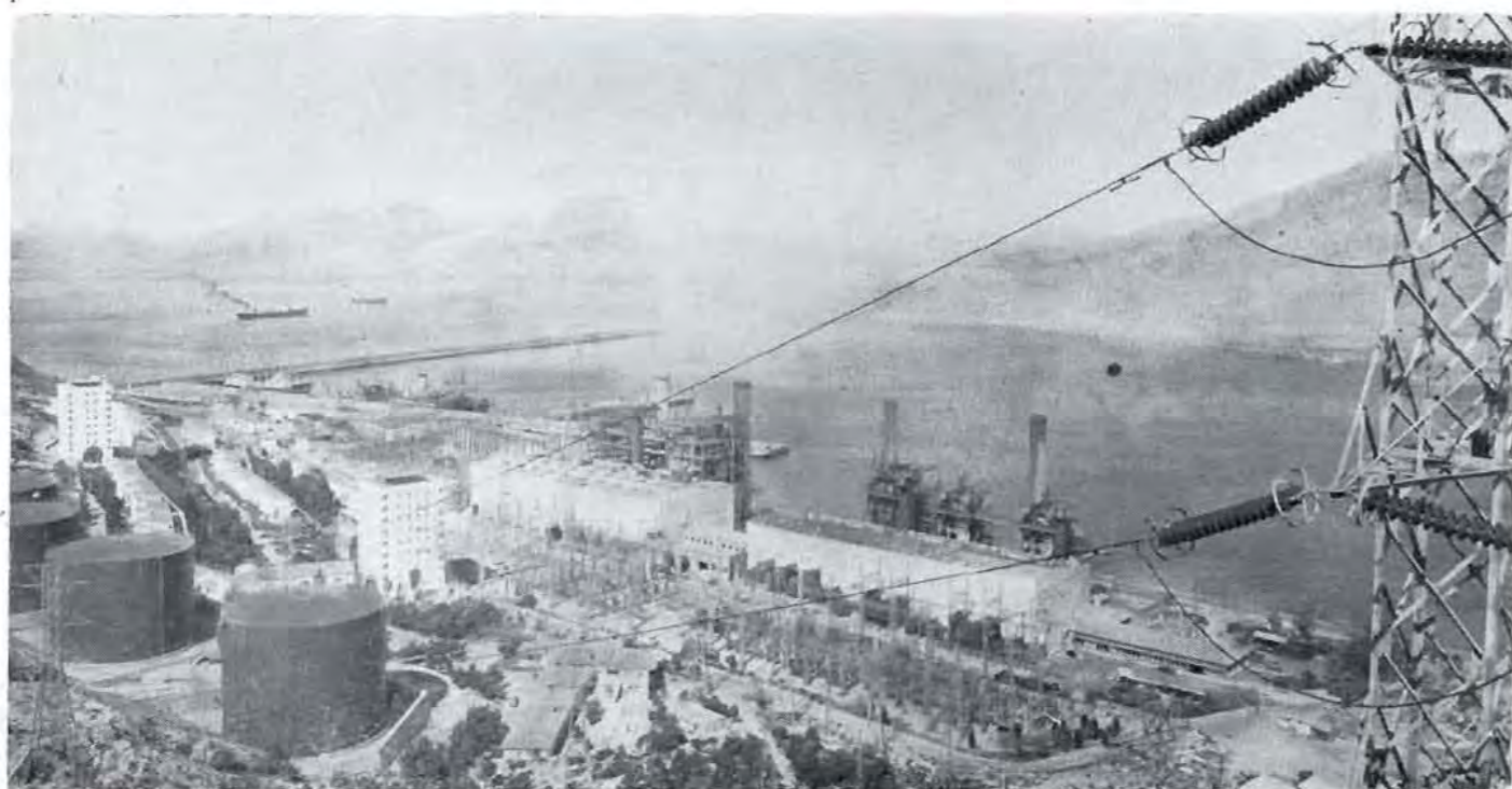
Térmica de ESCOMBRERAS - Potencia: 858.000 kw.
