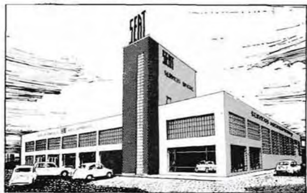
FILIAL DE VALLADOLID 6.ª ZONA. - 4.100 m 2 Ctra. de Madrid, Km. 188,4
