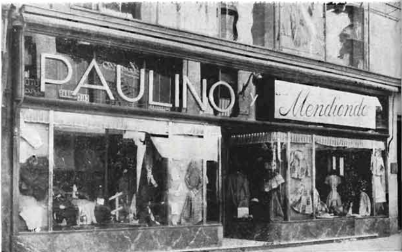
Paulino y Mendiondo; Peligros, 14
